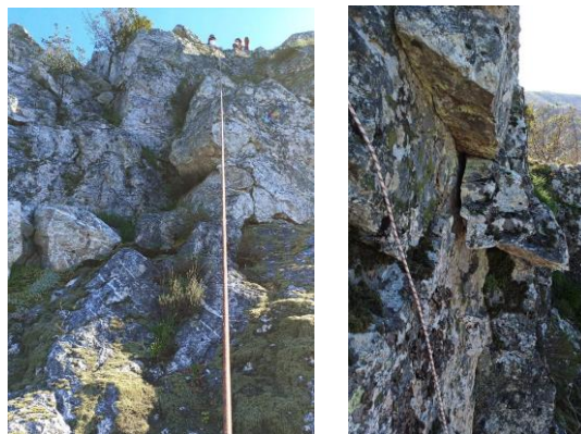
Fig. 1. Zona de apoio do miradouro estudada com a utilização de técnicas de escalada.
