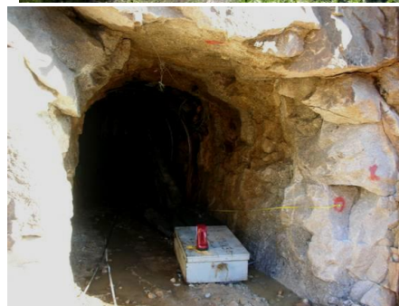
Fig. 2. Imagem da margem direita, com as trincheiras escavadas até meia encosta e entrada de uma galeria de reconhecimento.
