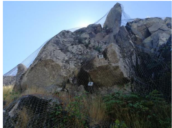
Fig. 1. Aplicação de rede de tripla torção e pregagens em talude de escavação.
