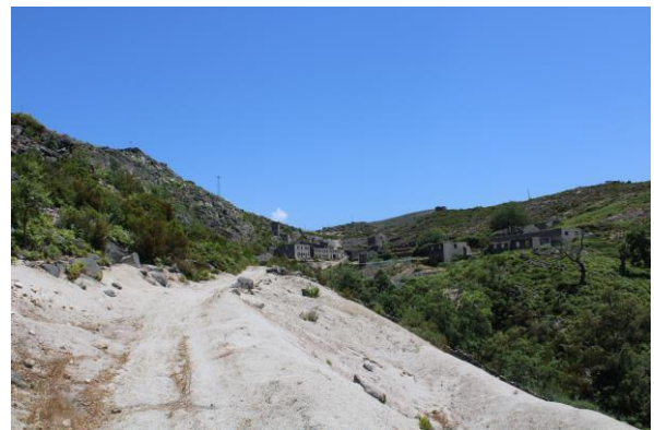
Fig. 1. Vista geral da mina de Regoufe, ao fundo as suas instalações abandonadas e em primeiro plano as escombreiras.
