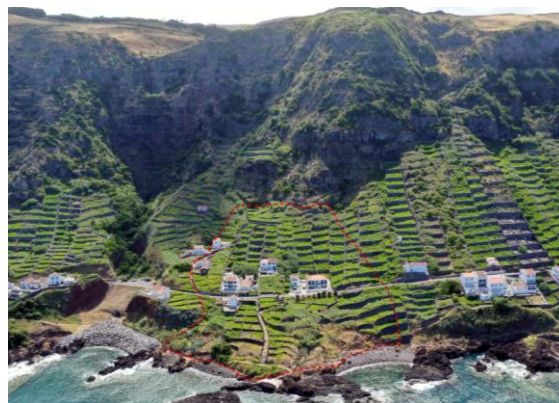
Fig. 1. Enquadramento do movimento de vertente em estudo (a linha a tracejado corresponde à delimitação do movimento de vertente).
